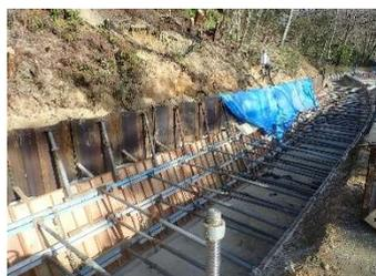
写真-6 型枠サポート状況
