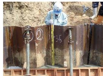
写真-4 打設高さ計測状況
