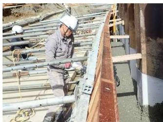
写真-5 型枠面からの締め固め
